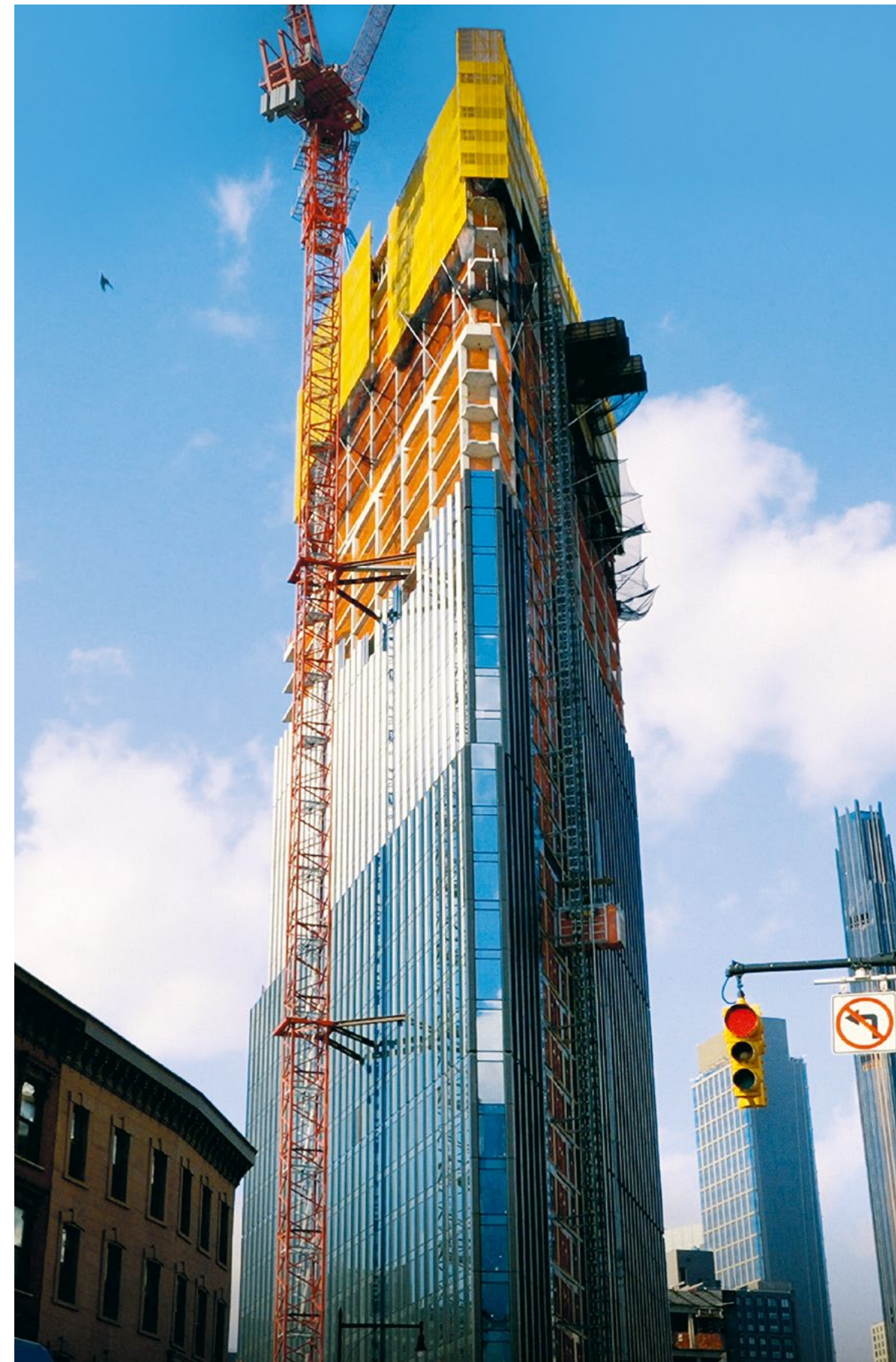
Die Doka-Rahmeneinhausung Xbright rund um das Bauwerk sorgt für höchste Sicherheit.
