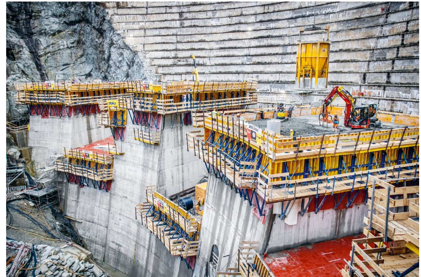
2 Beim Bau der Ersatzstaumauer Spitallamm kommen sowohl die Schalungslösungen als auch die digitalen Services von Doka zum Einsatz.
