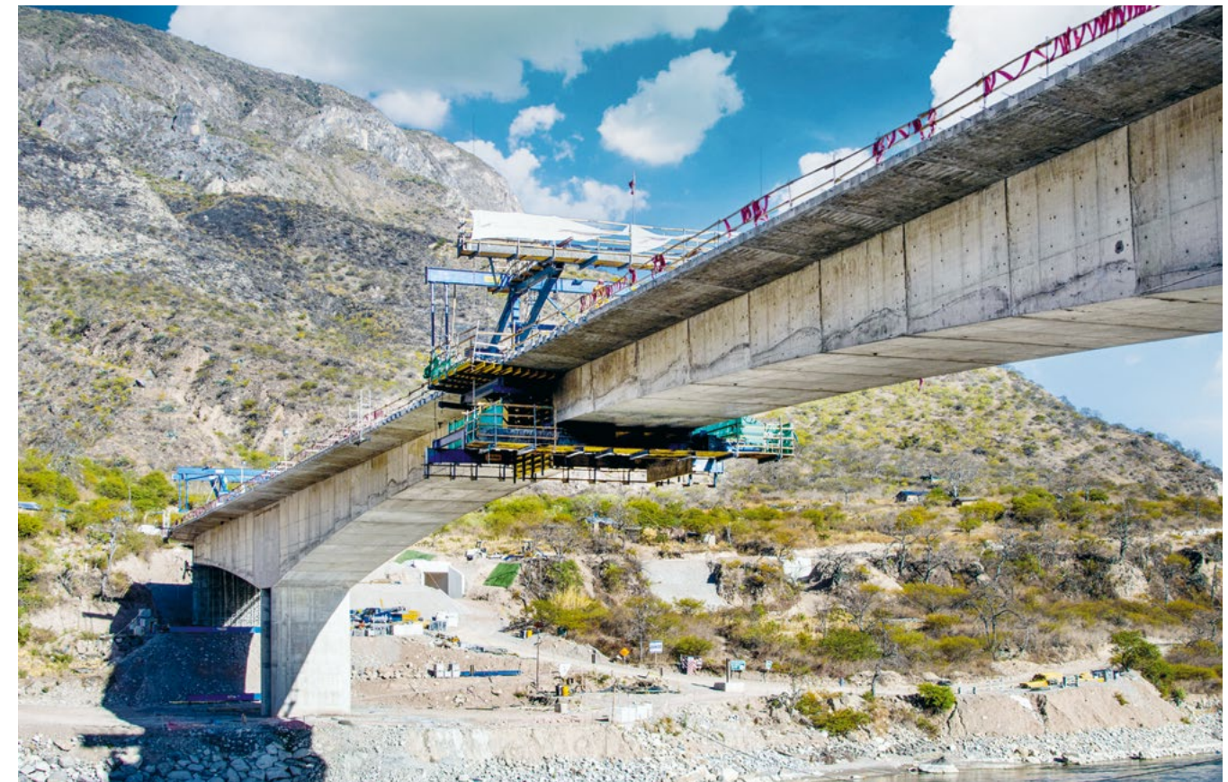
1, 2 Die Brücke über den Rio Pampas kurz vor dem Schließtakt der beiden Bauelemente, die sogenannte „Brücken-Hochzeit“.
