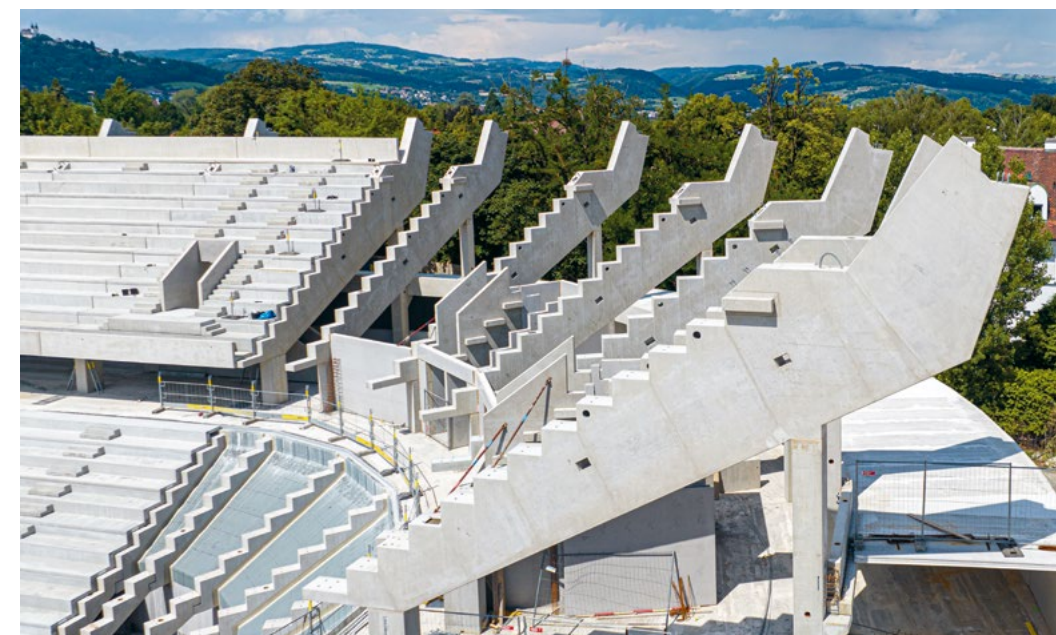
1, 2, 3 Beim Bau des neuen Linzer Stadions übernahm Doka eine tragende Rolle und lieferte die Sonderschalung für die Tribünenträger.
