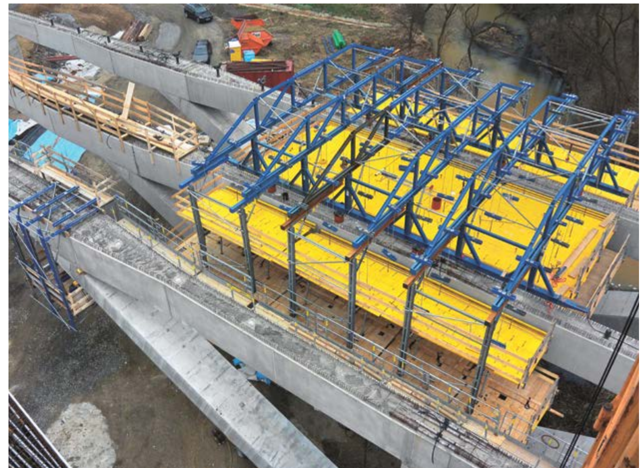
1 Beim Klappbrückenverfahren ist kein Lehrgerüst erforderlich, wodurch Zeit und Geld gespart wird. 2 Der Verbundschalwagen von Doka zeichnet sich durch hohe Flexibilität aus.
