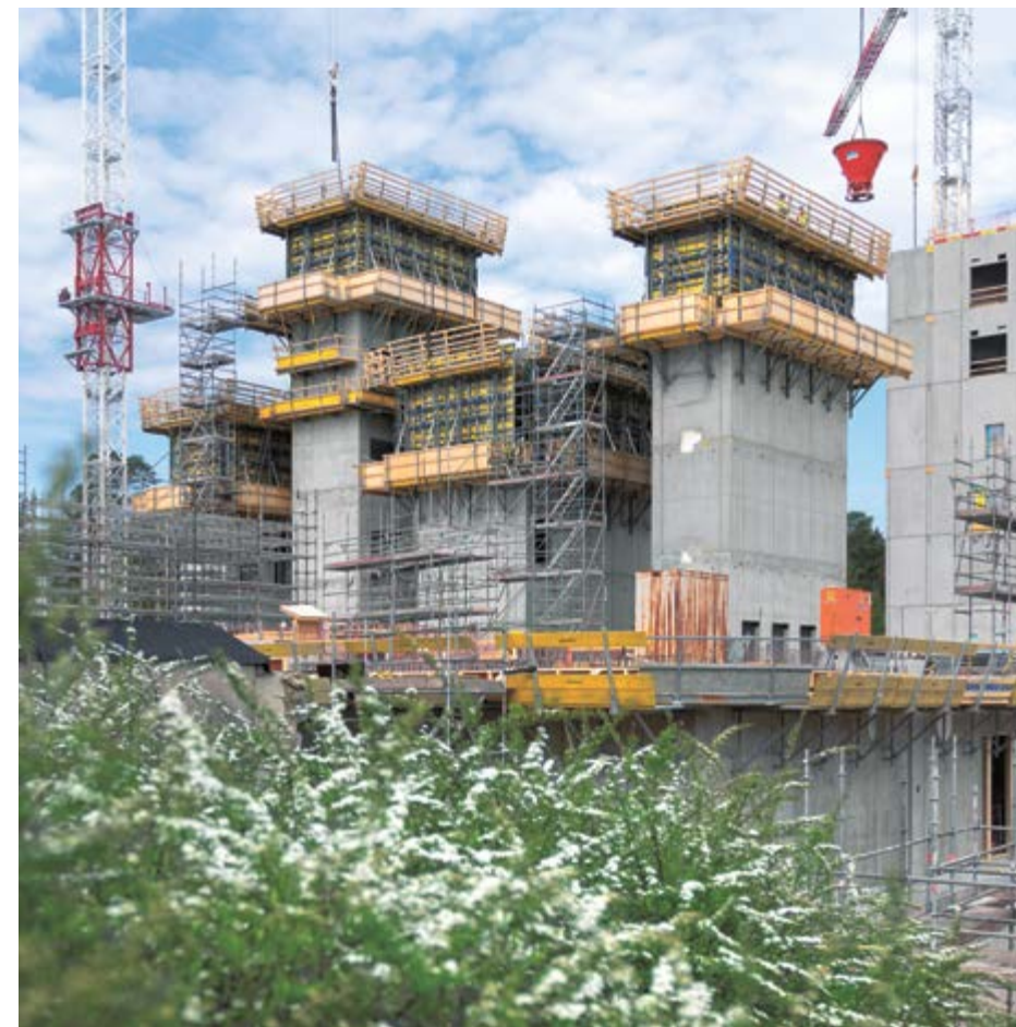
1, 2 Das Gebäude B des Krankenhauses entsteht mit der Kletterschalung MF240 und der Rahmenschalung Framax Xlife plus.
