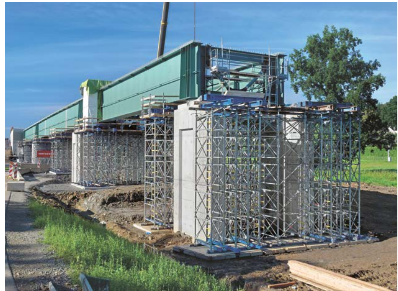
1 Die Brücke bei Soběslav in Südböhmen ist ein wichtiger Bestandteil der Modernisierung des tschechischen Bahnstreckennetzes.
