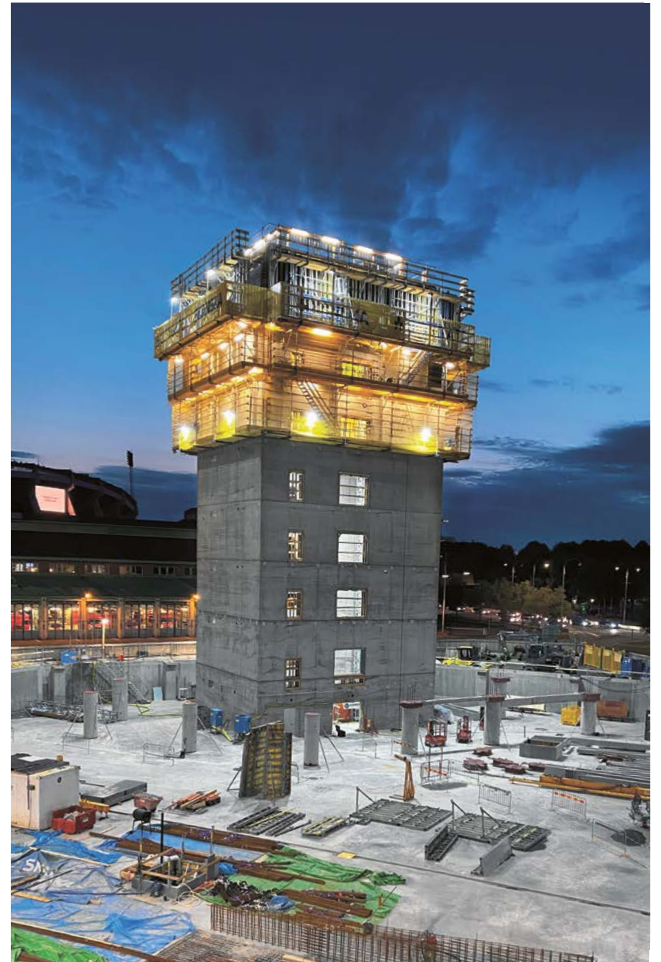
Der 144 m hohe Bürokomplex in Gårda, Göteborg wächst mithilfe der Selbstkletterschalung SKE50 plus in den Himmel.
